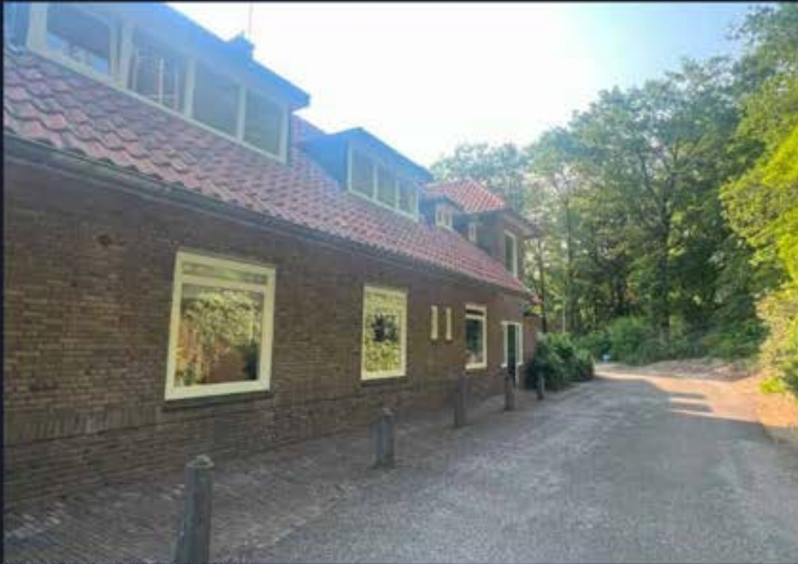
Overzicht gevel rechter vleugel
